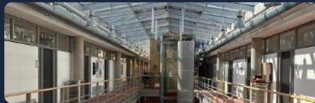
HITZESCHUTZ · DACHVERGLASUNG BÜROGEBÄUDE
