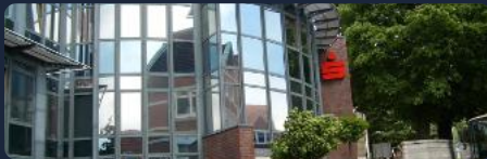
OBJEKTFOLIERUNG · SPARKASSE, SONNENSCHUTZ
