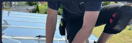
MONTAGE · AUSSENVERKLEBUNG AM GLASDACH
