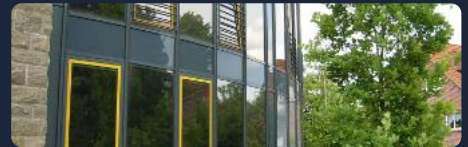
PRÄZISIONSFOLIERUNG · RUNDFASSADE EPPENDORF
