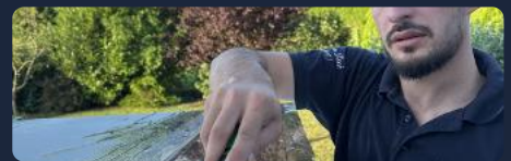
HANDWERK · RAKELTECHNIK AM GLASDACH
