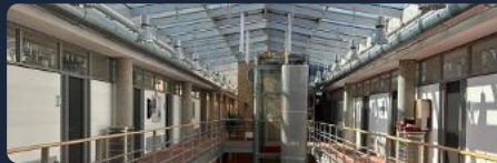
HITZESCHUTZ · DACHVERGLASUNG BÜROGEBÄUDE
