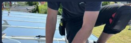
MONTAGE · AUSSENVERKLEBUNG AM GLASDACH
