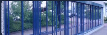
FASSADE · HITZESCHUTZ GEWERBEOBJEKT
