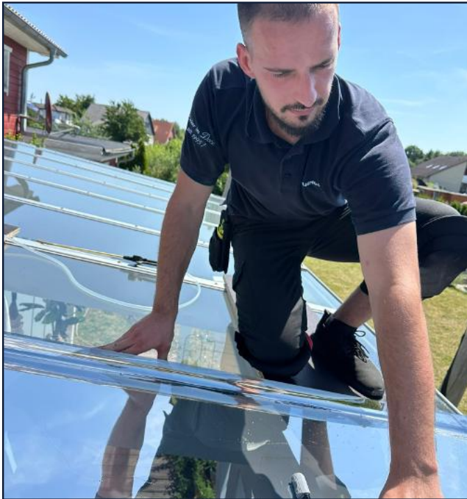
Handverlegung auf der Lichtkuppel – blasenfreie Verklebung, Kantenversiegelung vor Ort.
