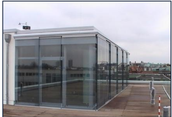
Referenz Glasfassade, Hamburg – Objektfolierung im Bestand
