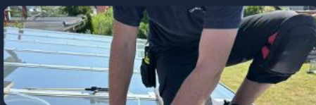
MONTAGE · AUSSENVERKLEBUNG AM GLASDACH
