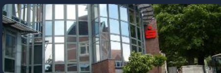
OBJEKTFOLIERUNG · SPARKASSE, SONNENSCHUTZ
