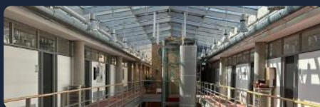
HITZESCHUTZ · DACHVERGLASUNG BÜROGEBÄUDE
