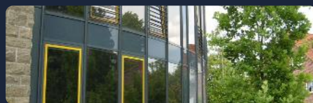
PRÄZISIONSFOLIERUNG · RUNDFASSADE EPPENDORF
